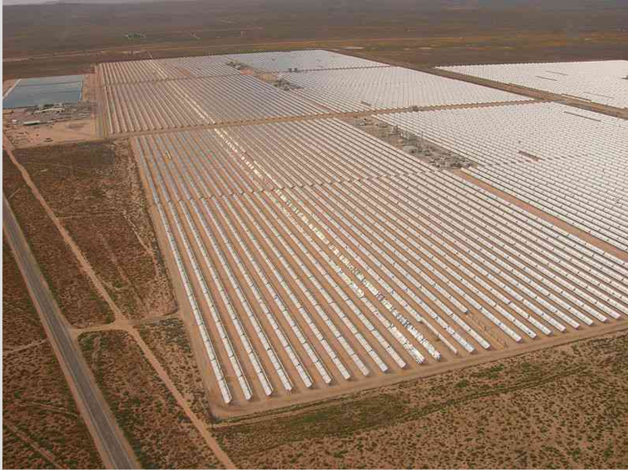
Centrale solaire en Californie (Kramer Junction)
